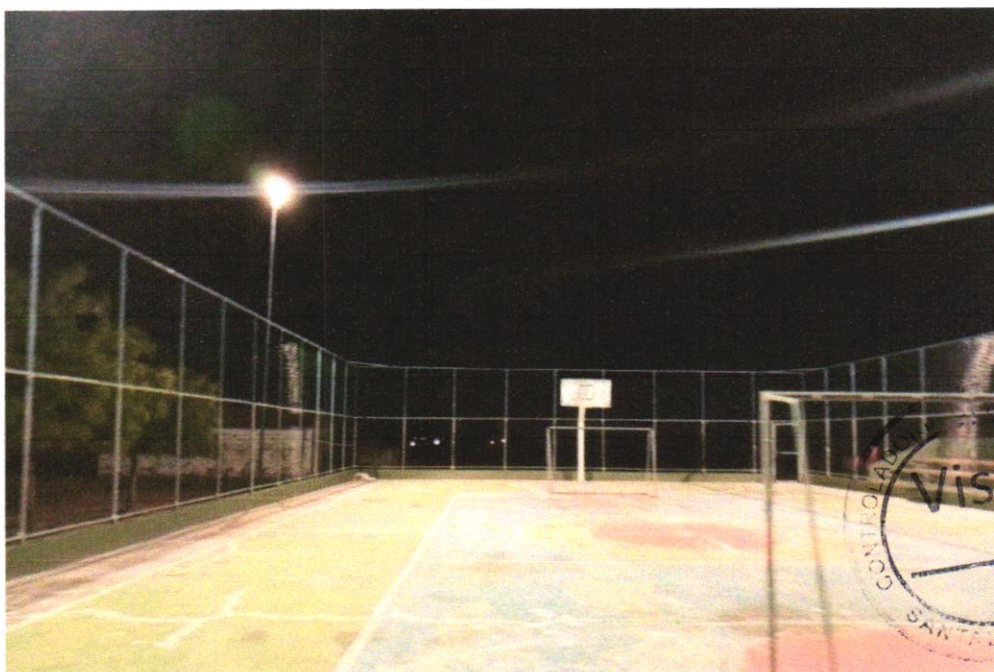
Foto 08 - ALAMBRADO PARA QUADRA POLIESPORTIVA, ESTRUTURADO POR TUBOS DE AÇO GALVANIZADO, (MONTANTES COM DIÂMETRO 2", TRAVESSAS E ESCORAS COM DIÂMETRO 1 ¼ ), COM TELA DE ARAME GALVANIZADO, FIO 10 BWG E MALHA QUADRADA 5X5CM (EXCETO MURETA). AF_03/2021
