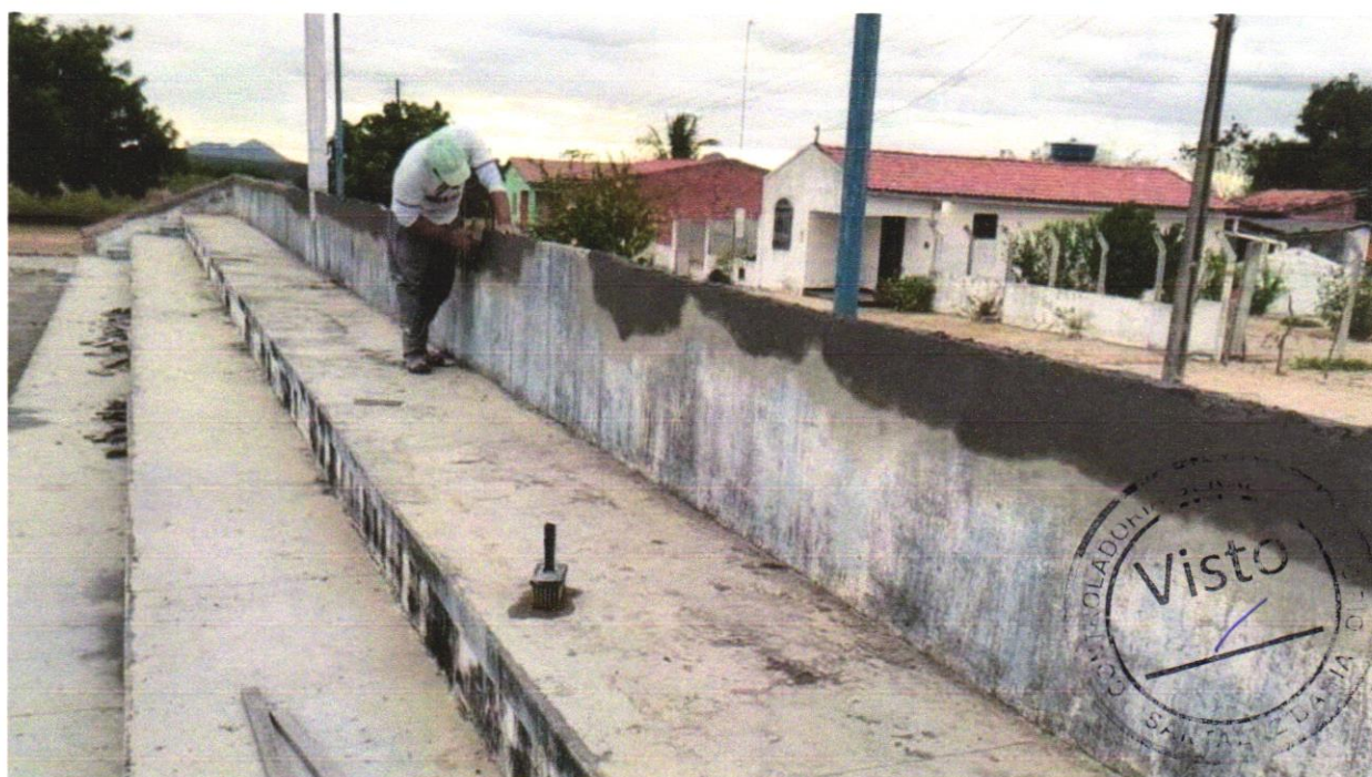
Foto 04- MASSA ÚNICA, PARA RECEBIMENTO DE PINTURA, EM ARGAMASSA TRAÇO 1:2:8, PREPARO MANUAL, APLICADA MANUALMENTE EM FACES INTERNAS DE PAREDES, ESPESSURA DE 10MM, COM EXECUÇÃO DE TALISCAS
