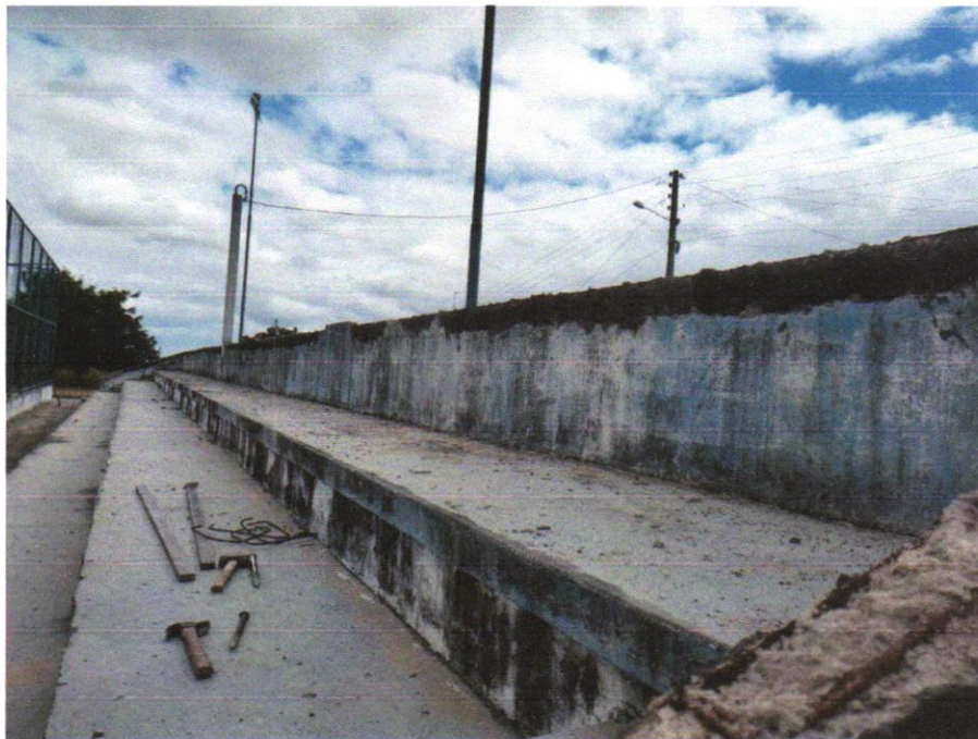
Foto 01 - Demolição de alvenaria de bloco de concreto de vedação
