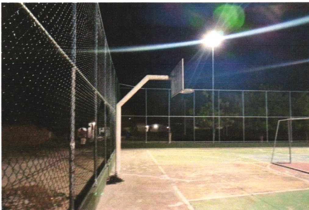
Foto 07 - ALAMBRADO PARA QUADRA POLIESPORTIVA, ESTRUTURADO POR TUBOS DE AÇO GALVANIZADO, (MONTANTES COM DIÂMETRO 2", TRAVESSAS E ESCORAS COM DIÂMETRO 1 ¼ ), COM TELA DE ARAME GALVANIZADO, FIO 10 BWG E MALHA QUADRADA 5X5CM (EXCETO MURETA). AF_03/2021
