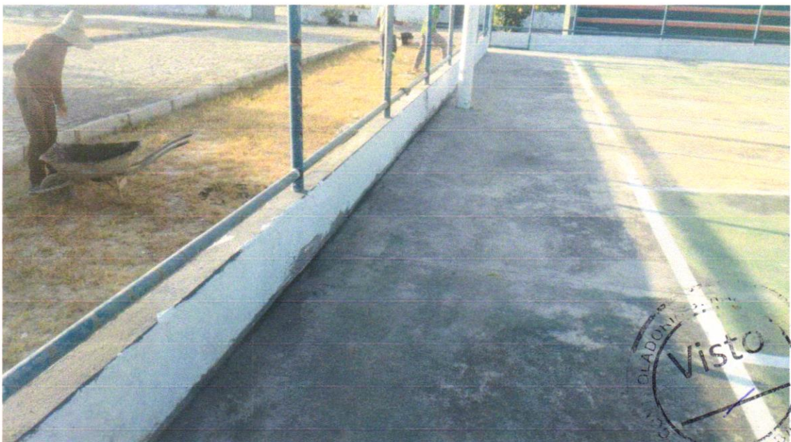
Foto 06 - PISO EM CONCRETO 20 MPA PREPARO MECÂNICO, ESPESSURA 7CM. AF_09/2020
