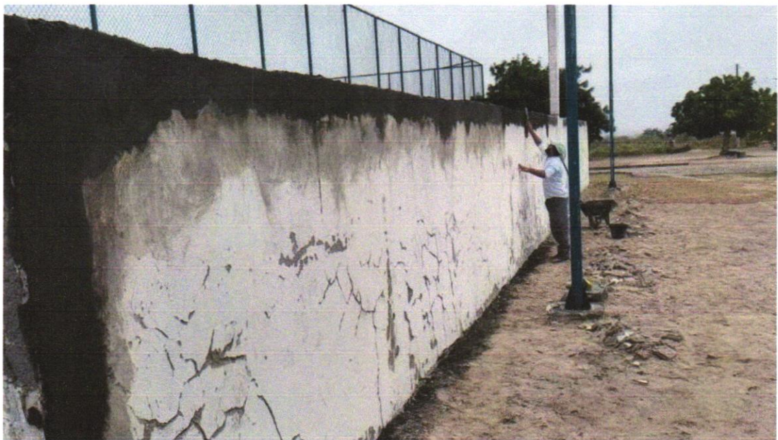
Foto 05 - MASSA ÚNICA, PARA RECEBIMENTO DE PINTURA, EM ARGAMASSA TRAÇO 1:2:8, PREPARO MANUAL, APLICADA MANUALMENTE EM FACES INTERNAS DE PAREDES, ESPESSURA DE 10MM, COM EXECUÇÃO DE TALISCAS
